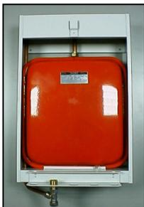
Jetzt das Ausdehnungsgefäß anbringen und dieses auf den flachen Flansch (oben) anschließen. Dann die restlichen Leitungsdurchführungen anbringen.
