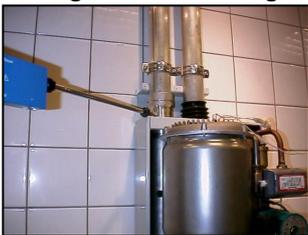
Die Messkappe an der Abgasleitung entfernen. Die Messsonde eines Abgasanalysegeräts (CO<sub>2</sub>-Messer) in die Messöffnung der Abgasleitung einbringen. Es ist für eine ausreichende Wärmeabfuhr über die Heizung zu sorgen.
