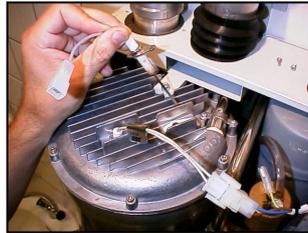
Der Ionisierungsstift ist ein Verschleißteil. In der Flamme kann sich bei hoher Temperatur eine isolierende Schicht bilden. Diese Schicht kann mit feinem Schmirgelpapier entfernt werden. Den Ionisierungsstift nicht mit grobem
