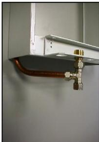
Die Leitungsdurchführung in die zweite Öffnung von links montieren und das T-Stück 15x15x15 auf diese Durchführung und die bereits montierte Leitung anschließen.
