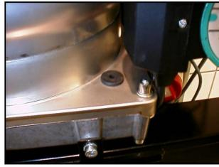
Den Kondensatbehälter mit Leitungswasser spülen. Dazu befindet sich oben am Kondensatbehälter eine Öffnung. Zunächst ist der Gummistopfen zu entfernen, bevor der Kondensatbehälter und der Abfluss mit sauberem Leitungswasser gespült
