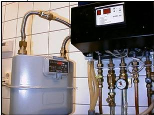
Zunächst wird die im Menü eingestellte Heizung-Leistung "P" auf 100% eingestellt. Dann lässt man das Gerät bei Schornsteinfegerfunktion auf Vollast laufen. Den Gasverbrauch messen. Wenn die festgestellte Belastungsabweichung nicht
