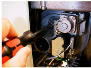
Den CO<sub>2</sub>-Wert am Rauchgasanalysegerät ablesen. Wenn der Wert nicht mit dem richtigen Wert für Propan G31 (9,8 % CO<sub>2</sub>) übereinstimmt, so verstellen Sie vorsichtig die Venturischraube, bis der richtige Wert erreicht wurde.
