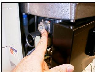
Den CO<sub>2</sub>-Wert bei minimaler Leistung für Propan G31 überprüfen (9,2 % CO<sub>2</sub>). Gegebenenfalls die Gasreglerschraube verstellen, bis der richtige Wert erreicht wurde.
