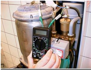
Direkte Messung des Ionisationsstroms in mikroAmpere Gleichstrom.
