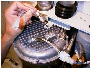
Den Stecker der der Ionisationssonde abziehen (Niedrigspannung).
