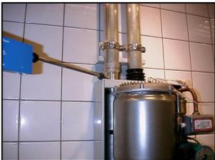
Der CO<sub>2</sub>-Nennwert für Erdgas liegt bei Vollast bei 8,8 Vol.%. Das Gerät braucht nicht gereinigt zu werden, wenn der gemessene CO<sub>2</sub>-Prozentsatz bei Vollast zwischen 8,8 % CO<sub>2</sub> und 9,4 % CO<sub>2</sub> liegt.
