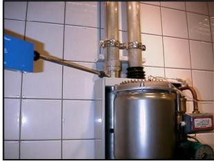
Ein Rauchgasanalysegerät (CO<sub>2</sub>-Messer) in die Messöffnung der Abgasleitung einbringen.
