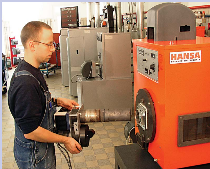
Der Brenner wird einfach in den Kessel eingeführt
