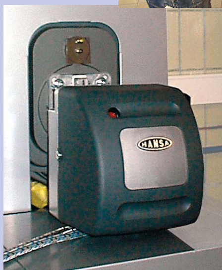
Nach dem Einbau
